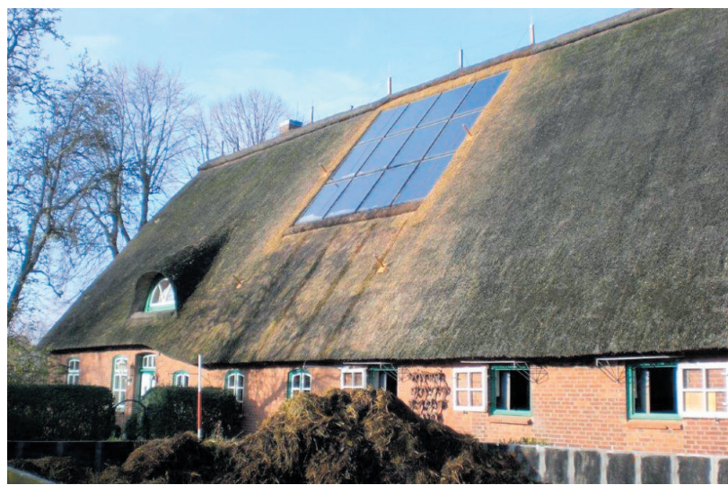
Eine moderne Solaranlage baute die Firma Burmester fachgerecht in ein traditionelles Reetdach ein. Foto: Burmester/hfr
